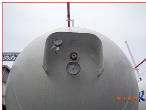
มาตรวัดระดับก๊าซเหลว
