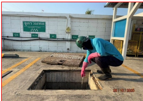
ภาพที่ 2.3-15 พนักงานทำความสะอาด บ่อดักน้ำมันและอูมิเนียม (Oil & Sand Trap)
